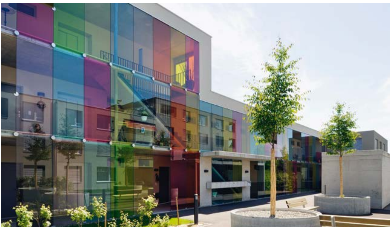
Immeuble Kilchwies / photo: Marco Blessano
