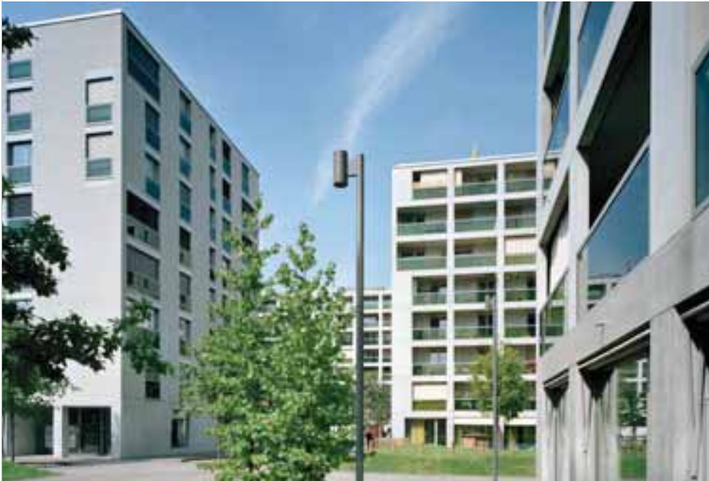
Brüstungsgläser aus SWISSLAMEX DESIGN/Wohnsiedlung Werdwies, Zürich
