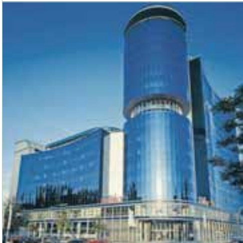
Hotelgebäude, Berlin, Deutschland
