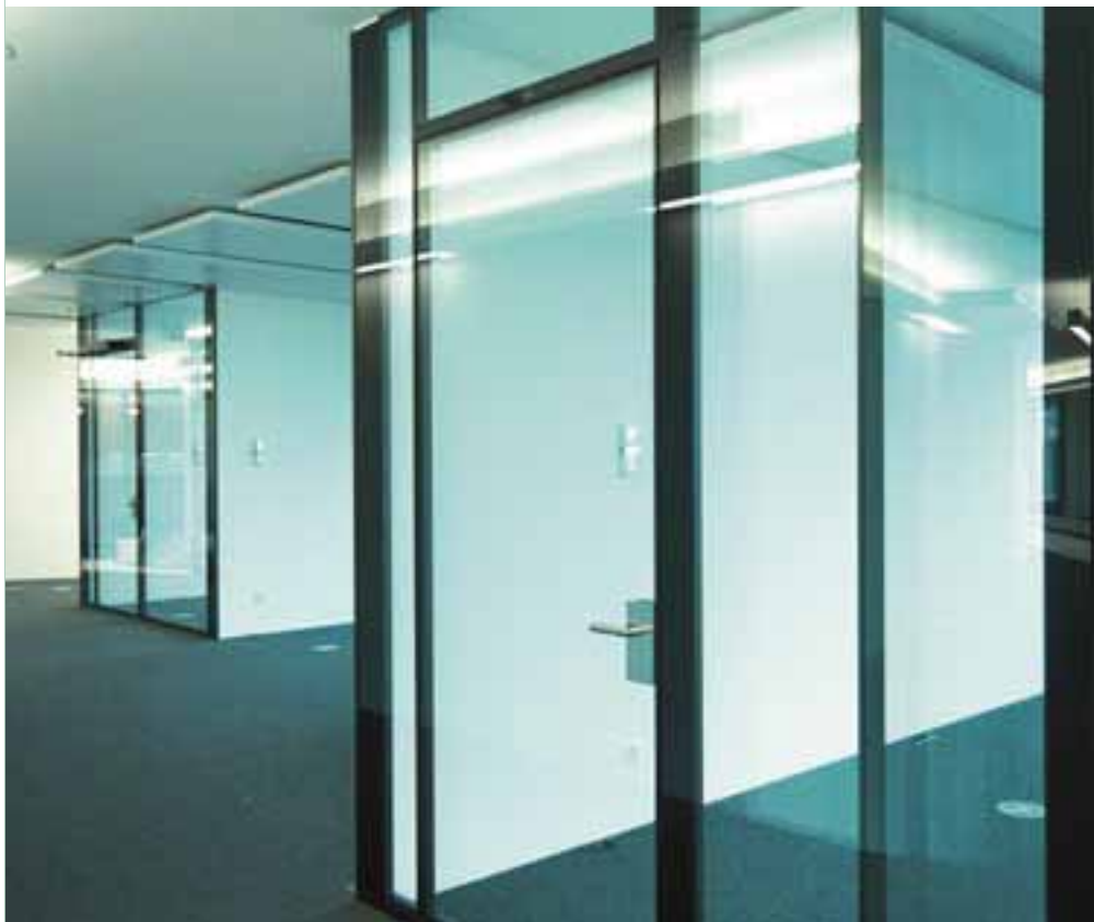
Raumtrennsystem SWISSDIVIDE TWO für erhöhten Schallschutz/Prime Tower – Swiss Platform, Zürich
